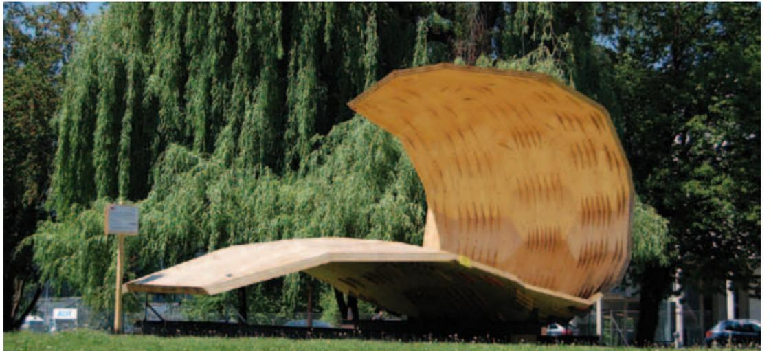
Die "Kobra", eine aus Fünf-, Sechs- und Siebenecken zusammengesetzte Freiformfläche aus KLH Massivholzplatten - endgültiger Standort in den Infeldgründen der TU Graz.
