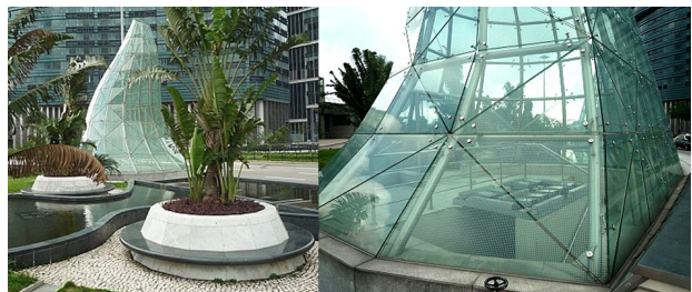
Abbildung 5: Freiformfläche aus Dreiecken
