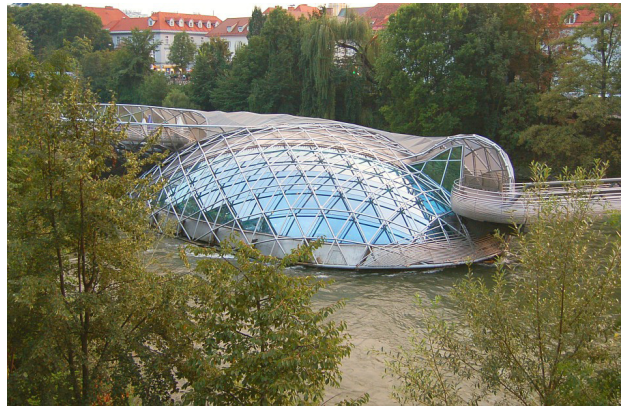
Abbildung 4: Dreiecksdiskretisierung am Beispiel der Murinsel in Graz
