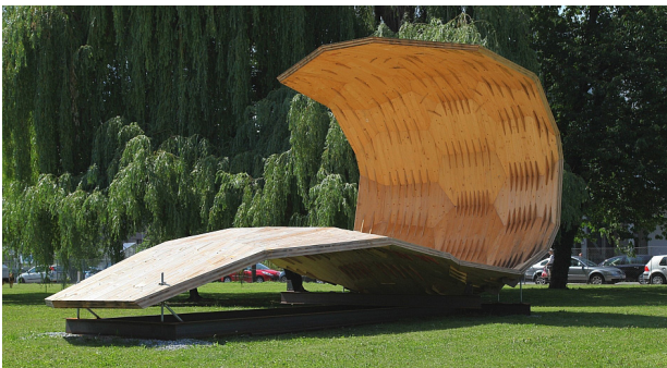
Abbildung 18: Der Prototyp am Campus der TU Graz in der Infeldgasse. Die Fläche ist auf einem Eisenträger mit 6 Lagerpunkten und einer zentralen Platte gelagert.
