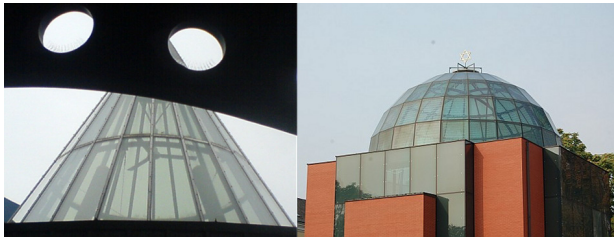
Abbildung 6: Diskretisierte Drehflächen am Beispiel eines Drehkegels (links, Foto: Lukas Pointner) und einer Halbkugel (rechts, Synagoge in Graz)
