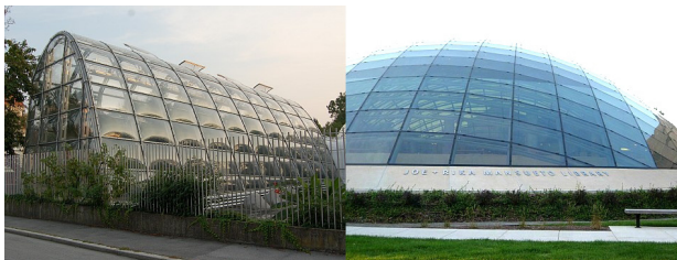
Abbildung 7: Diskretisierter parabolischer Zylinder (Botanischer Garten in Graz) und diskretisierte Schiebfläche (Chicago University Library, Foto: Bernhard Ortel)
