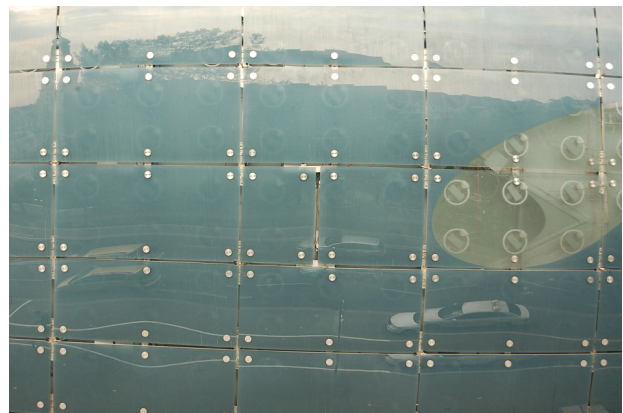
Abbildung 2: Diskretisierung (Zerlegung) einer doppelt gekrümmten Fläche in „gekrümmte Vierecke“ am Beispiel des Grazer Kunsthauses
