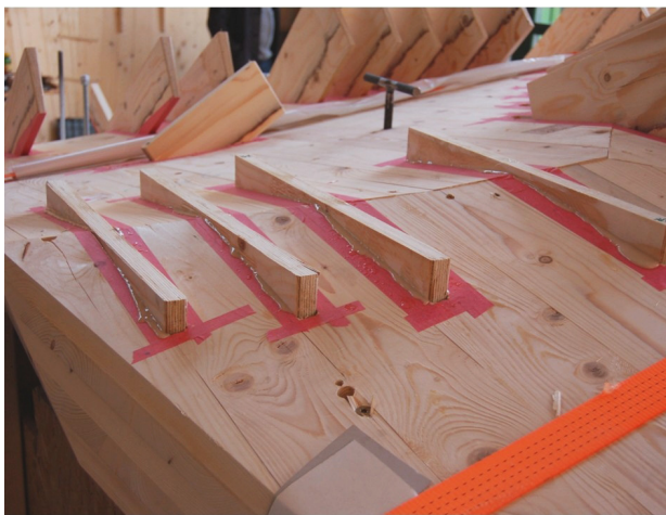
Abbildung 13: Die eingeleimten Kerto-Platten
